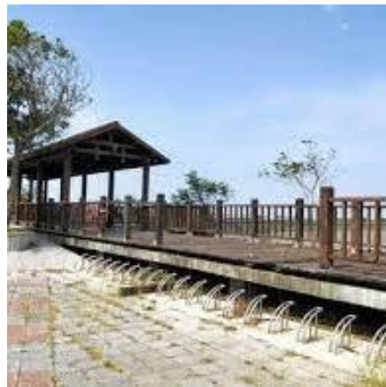
掌潭滯洪池景觀台
